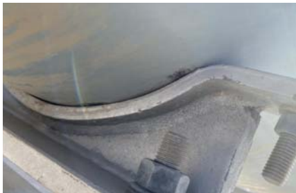
图 9 外壳在滑动支撑构架处漆皮被刚蹭
